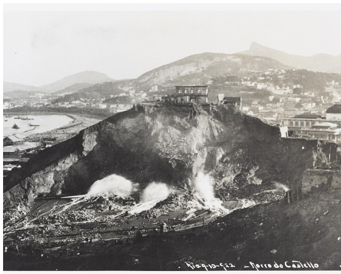
Imagem 1 - Augusto Malta, Ruínas do morro do Castelo; à esquerda, parte do aterro feito com a terra retrada do morro, 1922. Coleção Gilberto Ferrez, Acervo do Instituto Moreira Salles, Rio de Janeiro.
